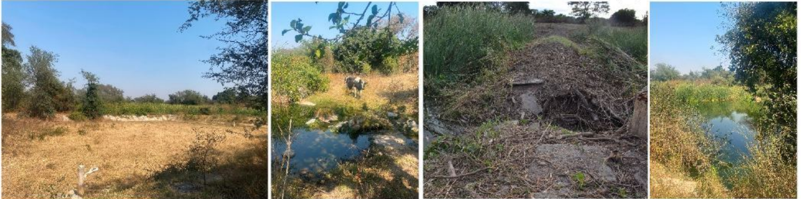
Ebenso begutachtete Mark Rall die stark renovationsbedürftige Wasserkläranlage der Schule.
